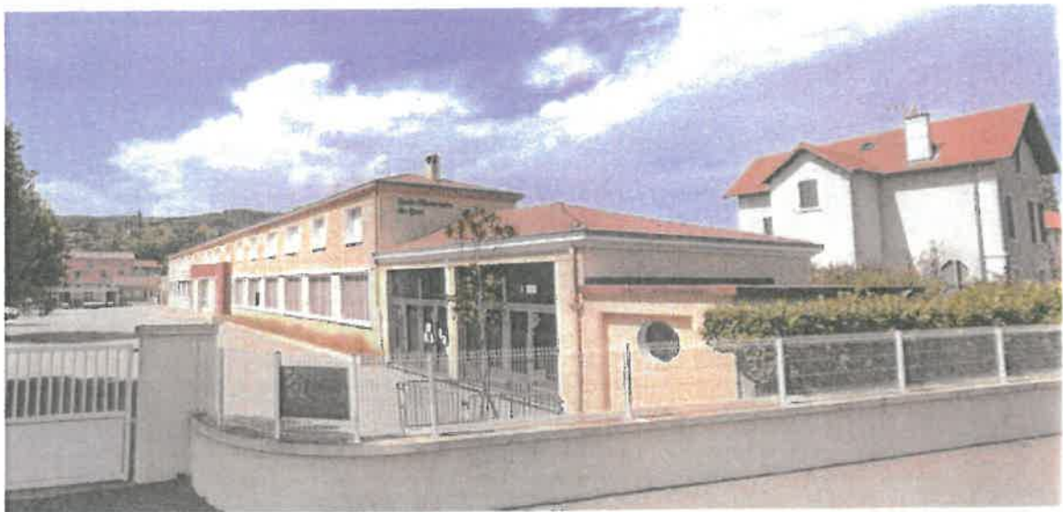
Toiture sud ouest , vue de la cour
